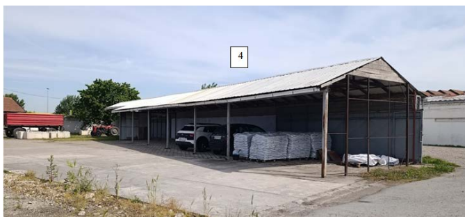
Слика 5: Изглед објекта број 4
